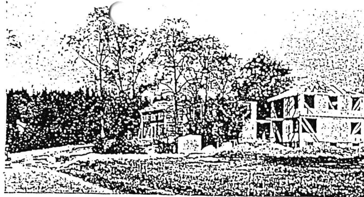
TYPISK PARTI MED HUS UNDER OPFØRELSE I SOGN HAVEBY
